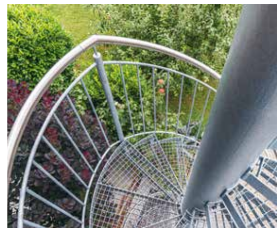
Zu erkennen ist das nach Vorschrift vierstufige Zwischenpodest, beginnend beim Knick im Handlauf.
