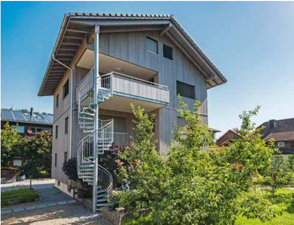
Spindeltreppe in Doppelfunktion: Trägt einerseits die Dachpfette und andererseits den Balkonboden.
