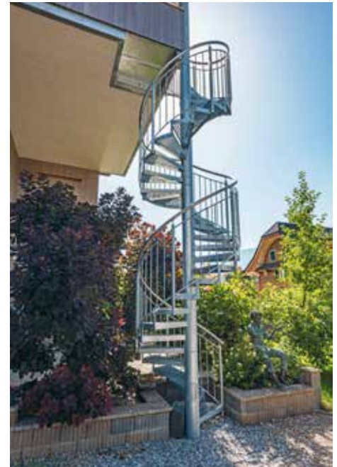
2¼ Windungen führen auf den Balkon. Das Staketengeländer mit Edelstahlhandlauf gewährt die notwendige Sicherheit.
